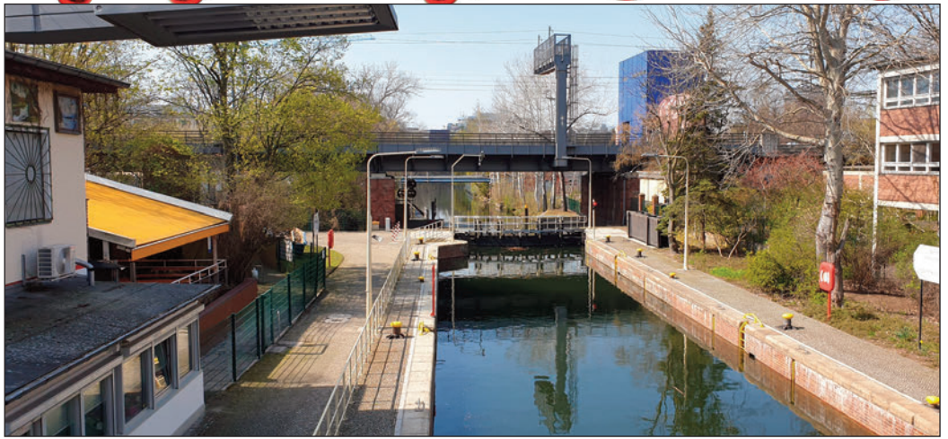
Unterschleuse mit dem Restaurant Schleusenkrug links.
