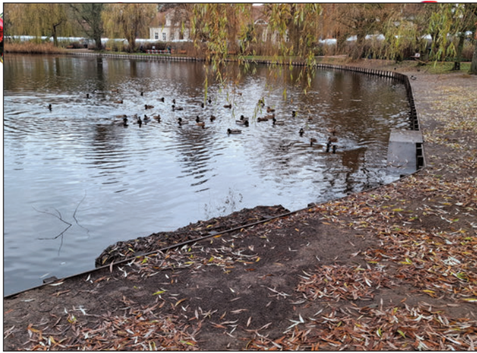
Neue Uferbefestigung und kleine Rampen sorgen für leichteren Ein- und Ausstieg der Wasservögel. Fotos: Heimann
