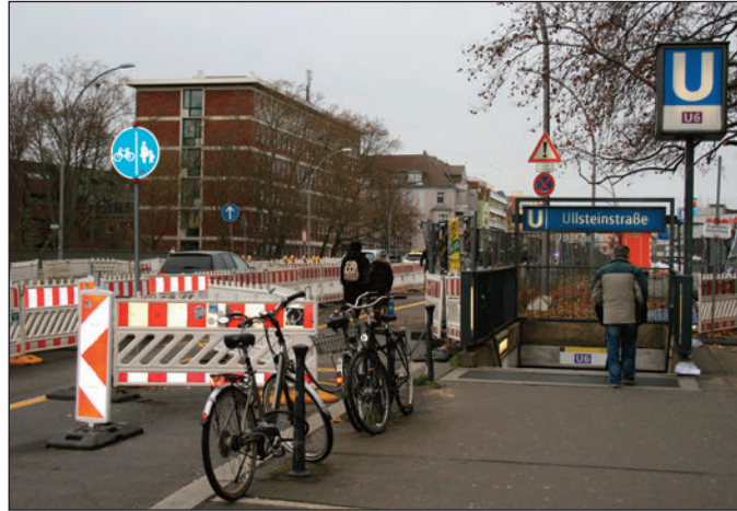
Am U-Bahnhof Ullsteinstraße läuft der Autoverkehr nur einspurig, frühere Fahrspuren wurden für Fußgänger und Radler abgetrennt.
